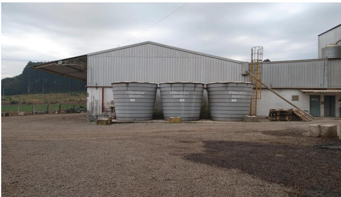
Aqui vemos os reservatórios de água, em primeiro plano, atrás temos o pavilhão da Fábricas com a varanda da expedição a esquerda. A direita temos a entrada lateral da Fábrica e o acesso a moega. Vemos que o pavilhão tem fechamento parcial em alvenaria rebocada e os oitões com fechamento em telhas metálicas.
