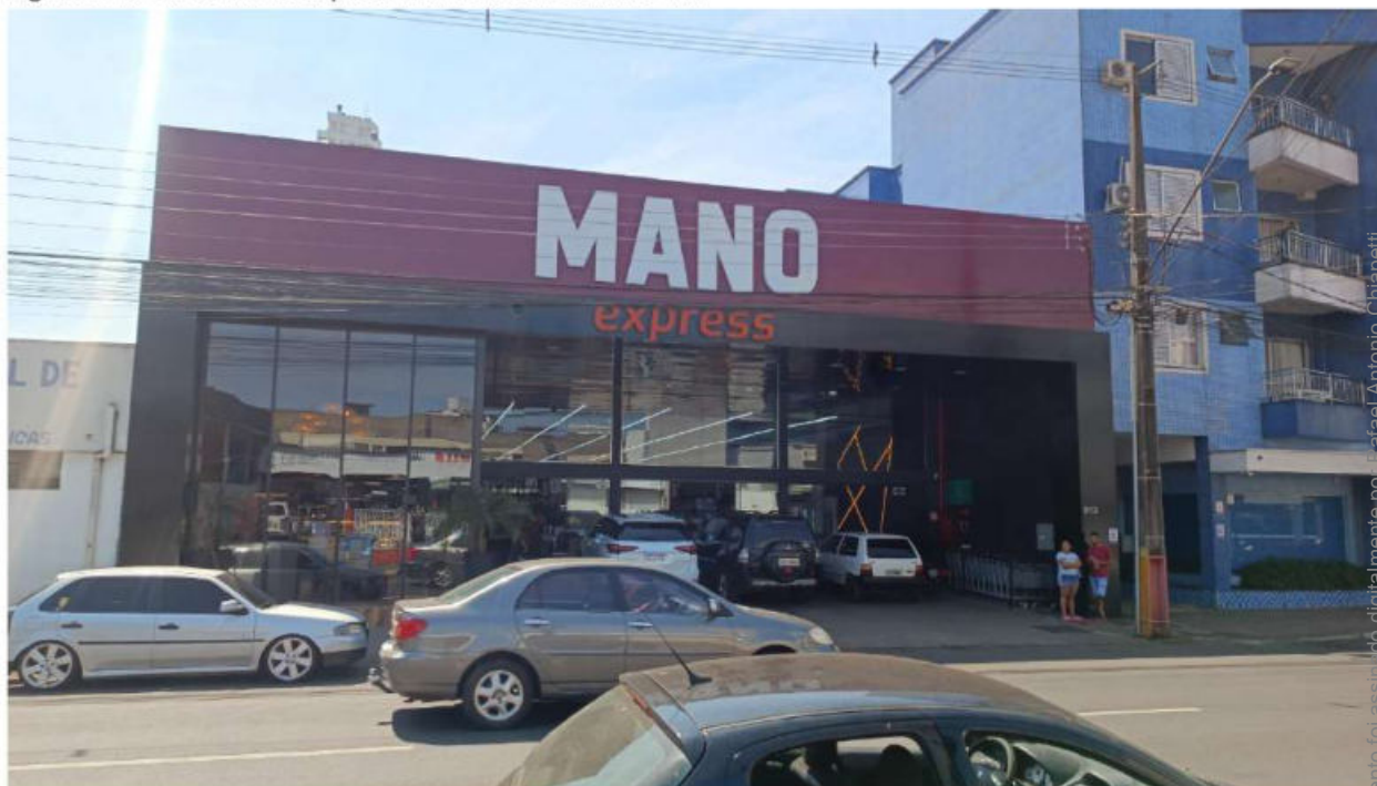
Figura 2: Fachada Mano Express FRANCISCO BELTRÃO-PR.
