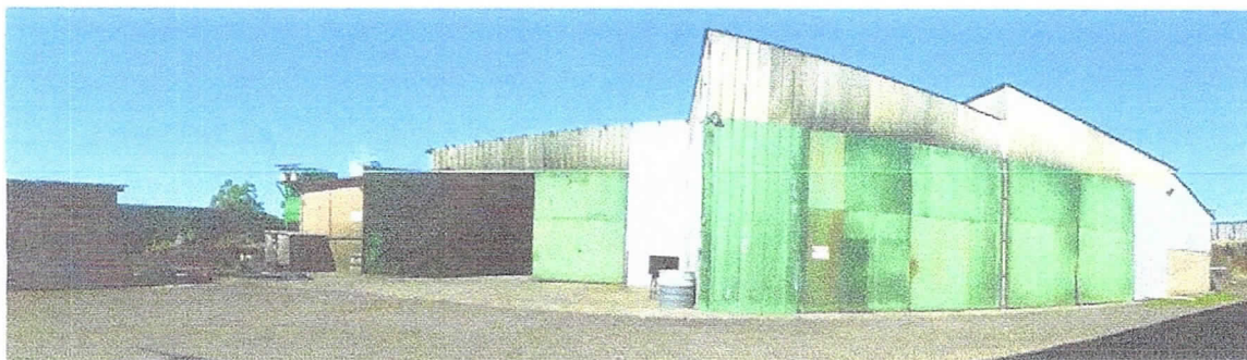
Foto 10 – vista externa da área construída em 2012 – pavilhão pintura.
