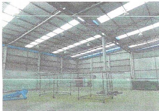
Foto 09 – vista interna da área construída em 2013.
