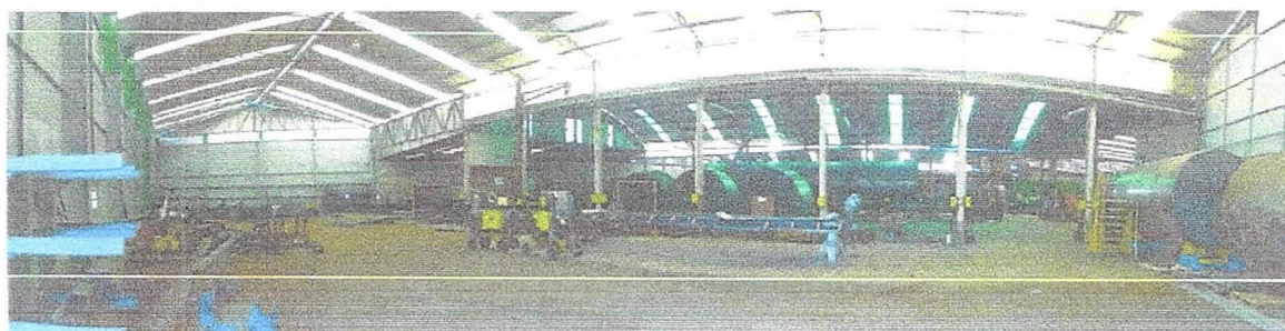
Foto 07 – vista interna do último pavilhão construído, vista a partir da porta dos fundos.
