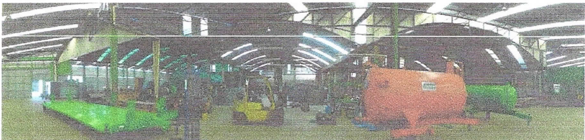
Foto 05 – vista interna do pavilhão da produção, mostrando as coberturas em meio arco e a integração dos espaços.
